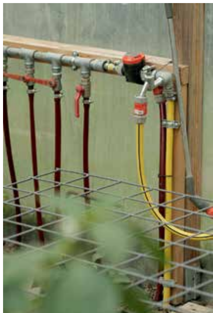
Die Tropfbewässerung versorgt gezielt die Pflanzenwurzeln. Die Blätter bleiben trocken.
